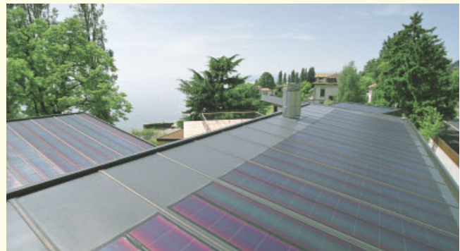
Installation PV avec cellules à couches minces en silicium amorphe. (Frédéric Pachoud)
