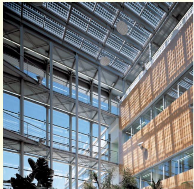
Une installation solaire qui non seulement produit de l'électricité mais qui fait aussi de l'ombre. (Daniele Domenicali)
