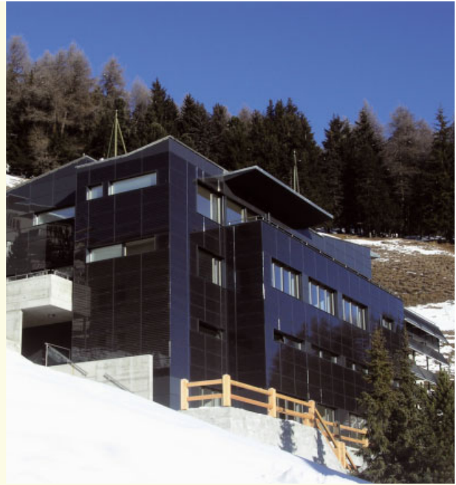
Intégration optimale au bâtiment. Une installation PV en guise de façade d'une maison privée. (Josef Troxler)
