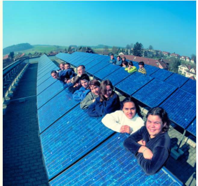
Modules solaires sur châssis sur le toit plat d'une école. (Patrick Lüthy)
