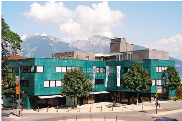
Bankgebäude Spiez Sonnenkollektorfläche 20m 2
