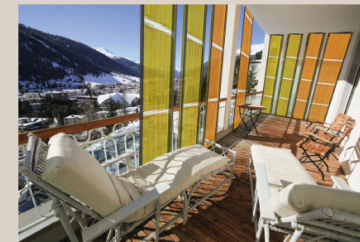
transparente Solarpanels als Trennwände und Sonnenschutz
