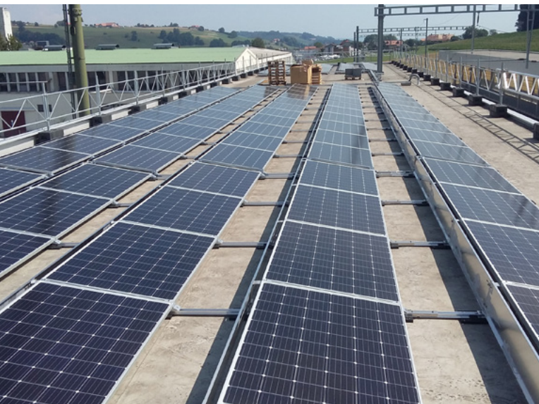
Bahnhof Belfaux, FR Foto: TPF, Julien Horner
