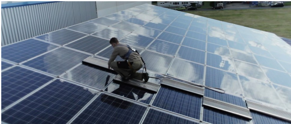
Abbildung 8: Einsatz Solar Multiboard, SMB Solar Multiboard GmbH
