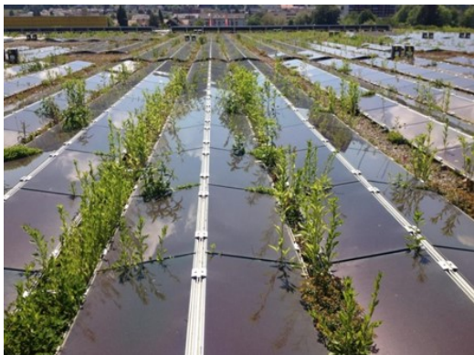
Abbildung 13: Bewuchs auf Gründach, ost-west-ausgerichtete PV-Anlage, Dr. Stephan Brenneisen, ZHAW Wädenswil
