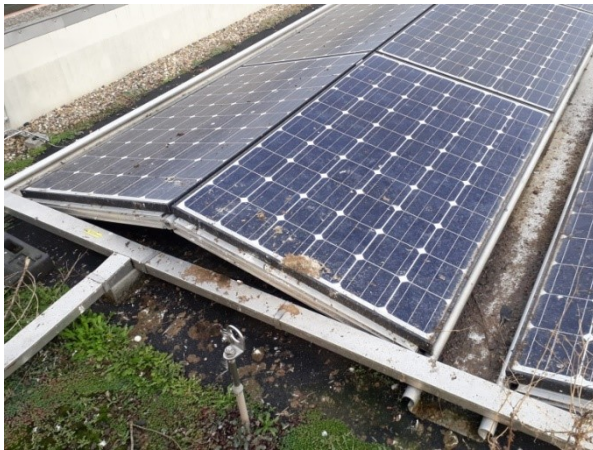
Abbildung 5: Verschmutzte Module, Jendra Power AG
