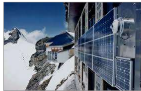
Fassade Jungfrauoch (3'450 m.ü.M.) Spezifischer Ertrag: 1'450 kWh/kW/a Anteil Winterproduktion: 46%
