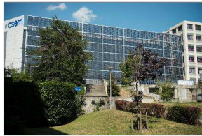
Fassade CSEM, Neuchâtel, Spezifischer Ertrag: 800 kWh/kW/a ca. 13% bifazialer Zusatzertrag Anteil Winterproduktion: 40%
