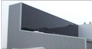
Fassade Nespresso, Avenches, Spezifischer Ertrag: 750 kWh/kW/a Anteil Winterproduktion: 42%
