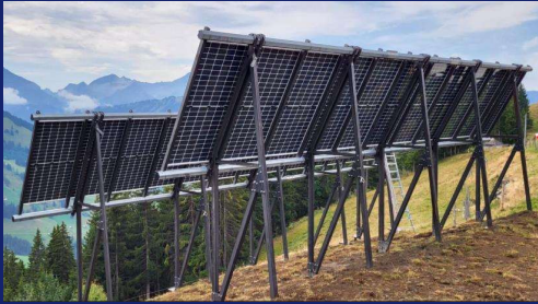
Modultischkonzept mit Modulen im Hochformat; (Bild: SolSarine, Green Energy Venture)
