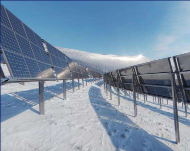
Tische mit drei Modulen im Querformat; Bild: MORGETENSOLAR
