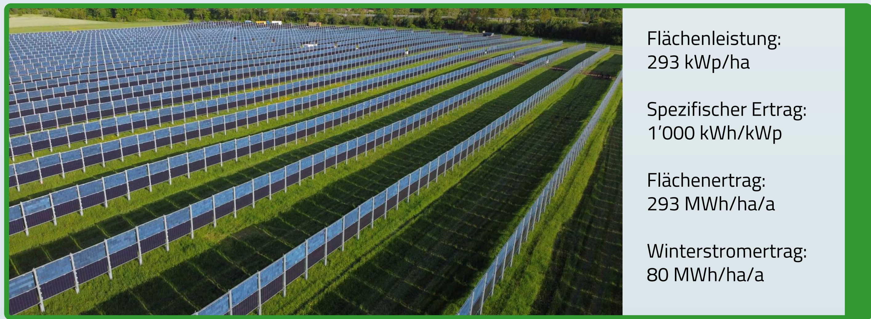
Abbildung 2: Beispiel einer vertikalen Agri-PV-Anlage mit bifazialen Modulen und einer Anlagenleistung von 4,1 MWp in Donaueschingen (Deutschland). Dieser Anlagentyp eignet sich insbesondere für Dauergrünland. Der Modulreihenabstand beträgt hier 10 Meter, der Abstand der Modulunterkante zum Boden 0,8 Meter. Es sind zwei querliegende Modulreihen übereinander installiert. Die aufgeführten Kennwerte resultieren aus der Simulation mit PVsyst für den Referenzstandort Zürich-Kloten mit einer jährlichen Einstrahlung von 1'163 kWh/m 2 .
