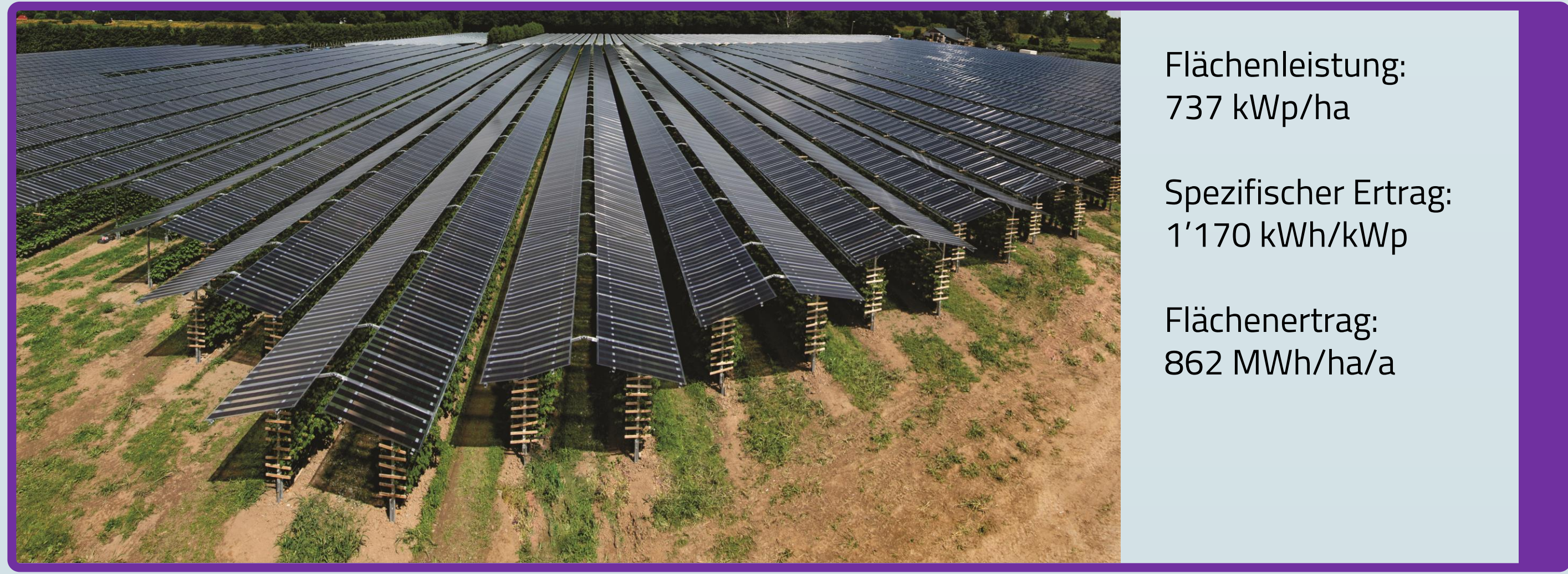
Abbildung 3: Beispiel einer Agri-PV-Anlage über einer Dauerkultur mit fest installierten Modulen und einer Anlagenleistung von 2,6 MWp. Die Anlage befindet über einer Himbeeren-Plantage in Zevenaar (Niederlande). Mit der Anlage konnten Folientunnel ersetzt werden. Es kommen semitransparente Module mit einer erhöhten Lichtdurchlässigkeit zum Einsatz. Die aufgeführten Kennwerte resultieren aus der Simulation mit PVsyst für den Referenzstandort Zürich-Kloten mit einer jährlichen Einstrahlung von 1'163 kWh/m 2 . Für die Referenzanlage wurden PV-Module mit einer Lichtdurchlässigkeit von 54 % berücksichtigt.
