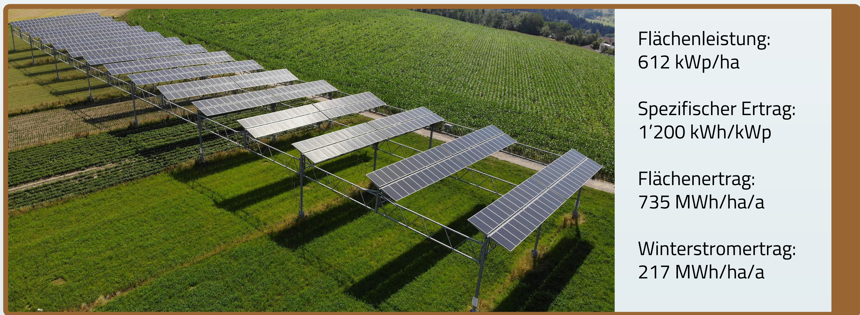
Abbildung 1: Beispiel einer Agri-PV-Anlage mit einer Anlagenleistung von 194 kWp über einer Ackerkultur mit fest installierten Modulen. Die Anlage steht in Heggelbach (Deutschland). Die bifazialen Module sind auf 5,5 Meter Höhe installiert und der Stützenabstand in Längsrichtung beträgt 19 Meter. Die aufgeführten Kennwerte resultieren aus der Simulation mit PVsyst für den Referenzstandort Zürich-Kloten mit einer jährlichen Einstrahlung von 1'163 kWh/m 2 .
