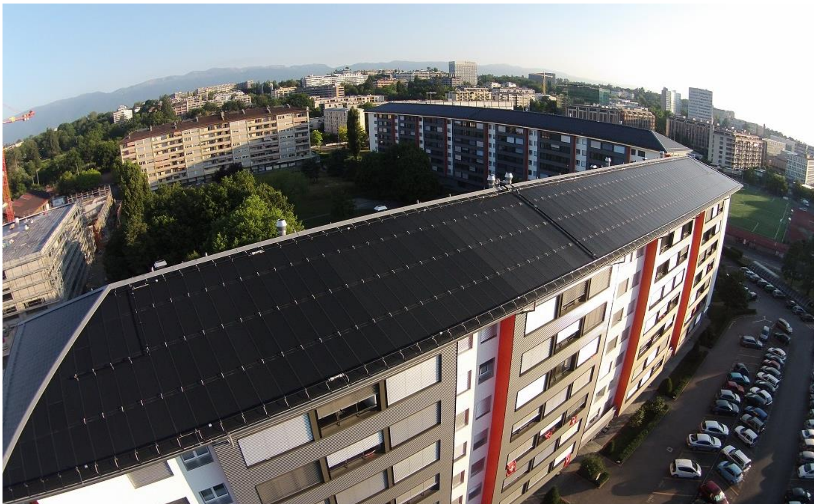
«La Cigale» in Genf, ICESOL System mit 1'680 m 2 Solardach AS, Schweizer Solarpreis 2014
