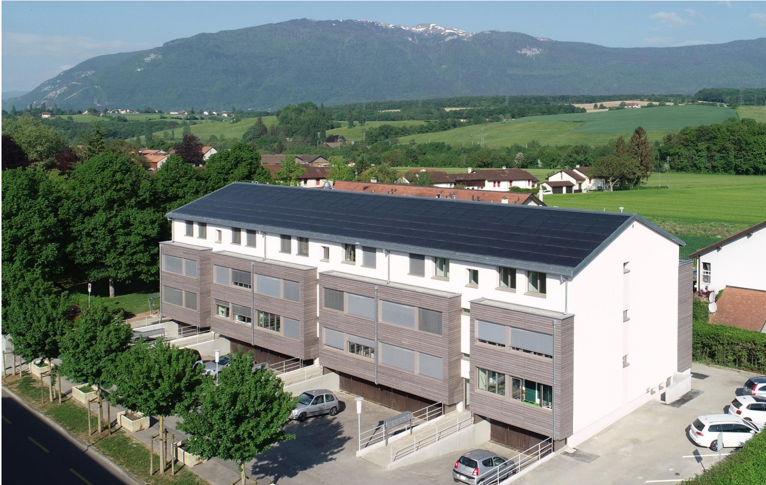
«Bellegarde» in Bernex (Genf), ICESOL System mit PV und Solarthermie, dachintegriert
