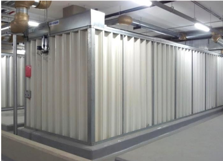
Containerförmige Eisspeicher
