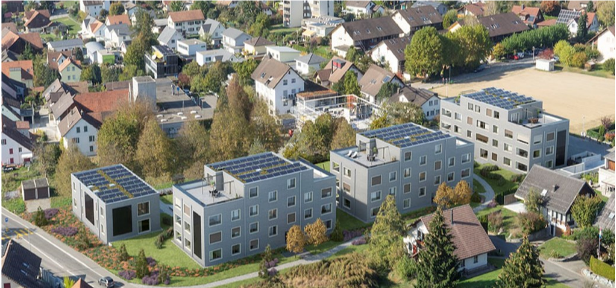
Abbildung 47: Areal in Möriken AG mit PV-Anlagen auf Dach, Fassaden und Terrassenbrüstungen (Quelle: Setz Architektur AG)
