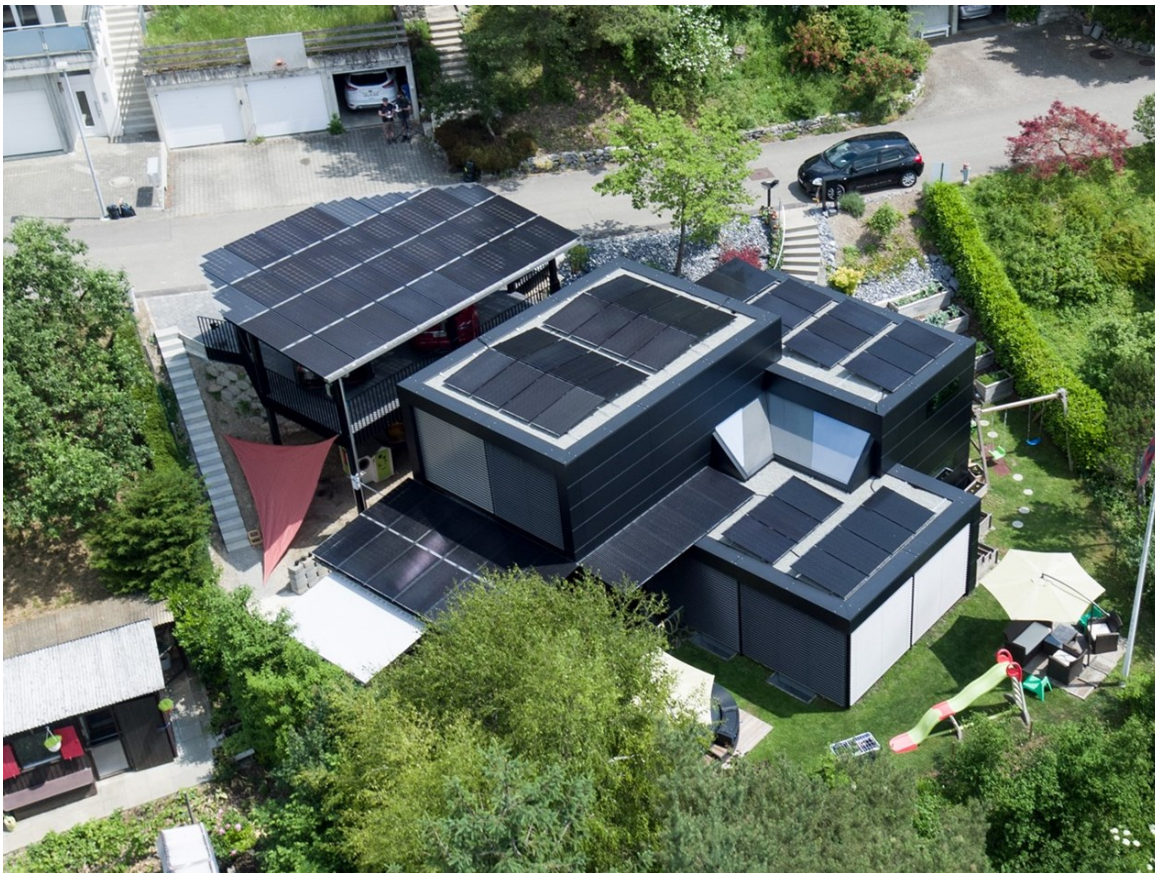
Abbildung 32: EFH in Remigen AG mit verteilter PV-Anlage auf Dach und Carport, 2 Elektromobile (Quelle: Delfosse AG)
