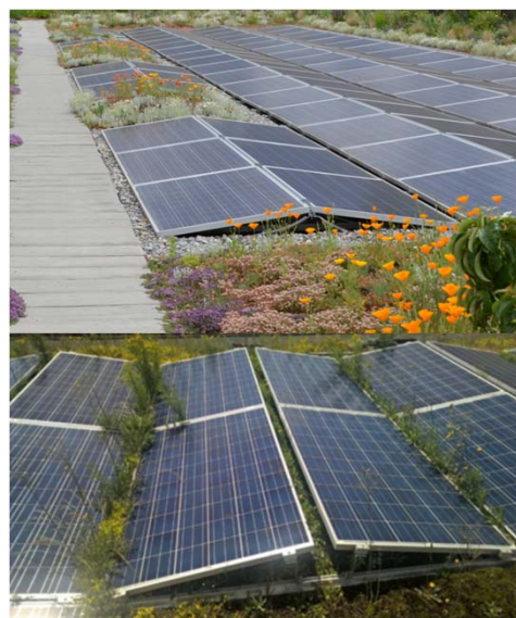
Bild: ZHAW PV Dachanlage ohne räumliche Trennung
