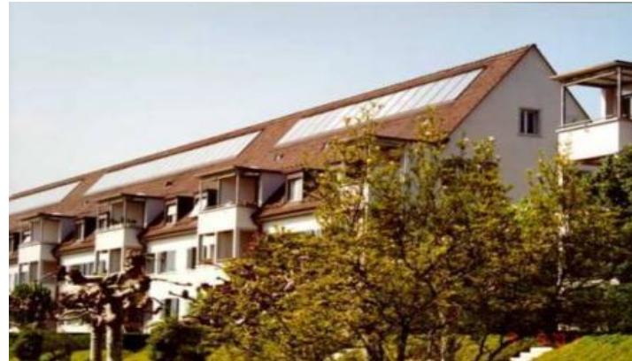
Genossenschaft Hofgarten Zürich, 300 m 2 Kollektoren (Brauchwasservorwärmung)
