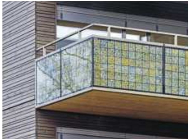
BALKONBRÜSTUNGEN MIT POLIKRISTALLINEN PV-MODULEN FÜR MEHRFAMILIENHAUS ZWYSSIGSTRASSE, ZÜRICH
