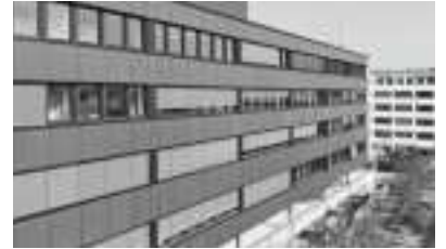
LETZIPARK ZÜRICH Produkt: Megasol Energie AG, Deitingen PV-Planer: energiebüro AG, Zürich PV-Installateur: Planeco GmbH, Münchenstein
