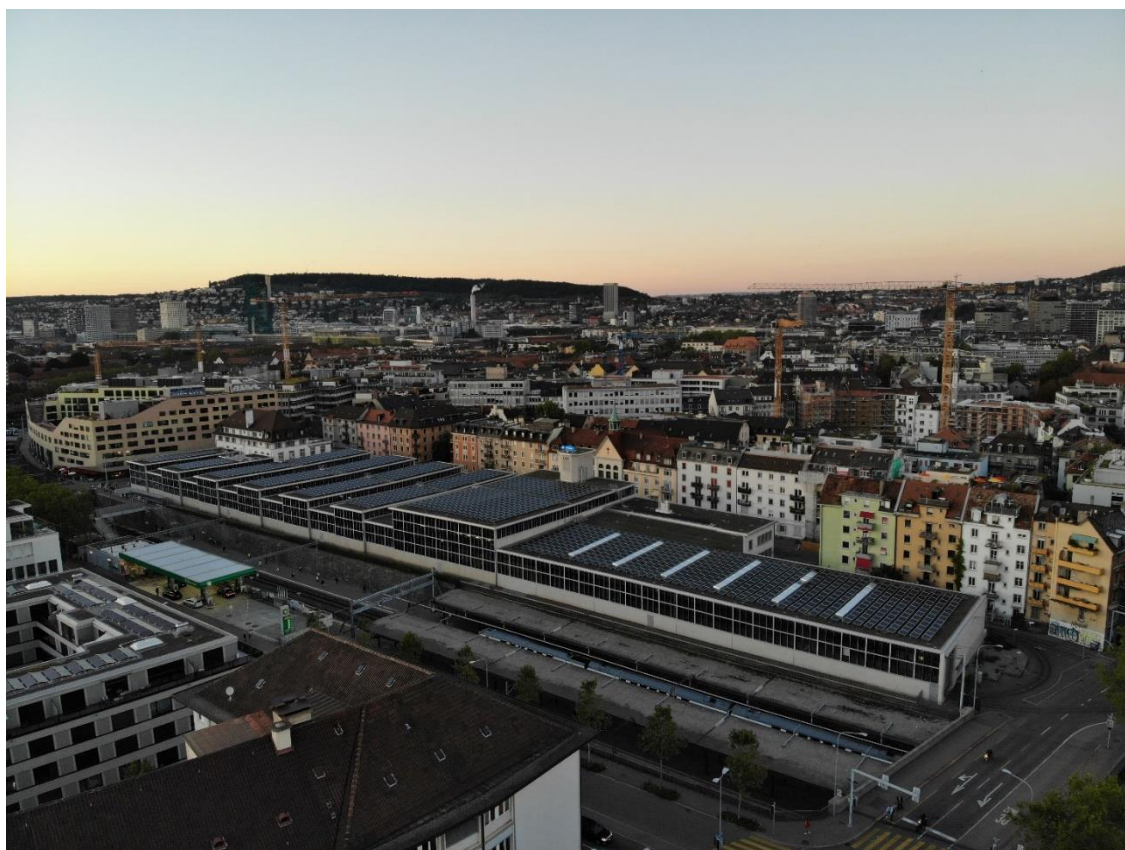
Abbildung 30: Neue PV-Anlage auf dem Dach des Tramdepots Elisabethenstrasse, Bild: Basler & Hofmann AG, Christof Bucher
