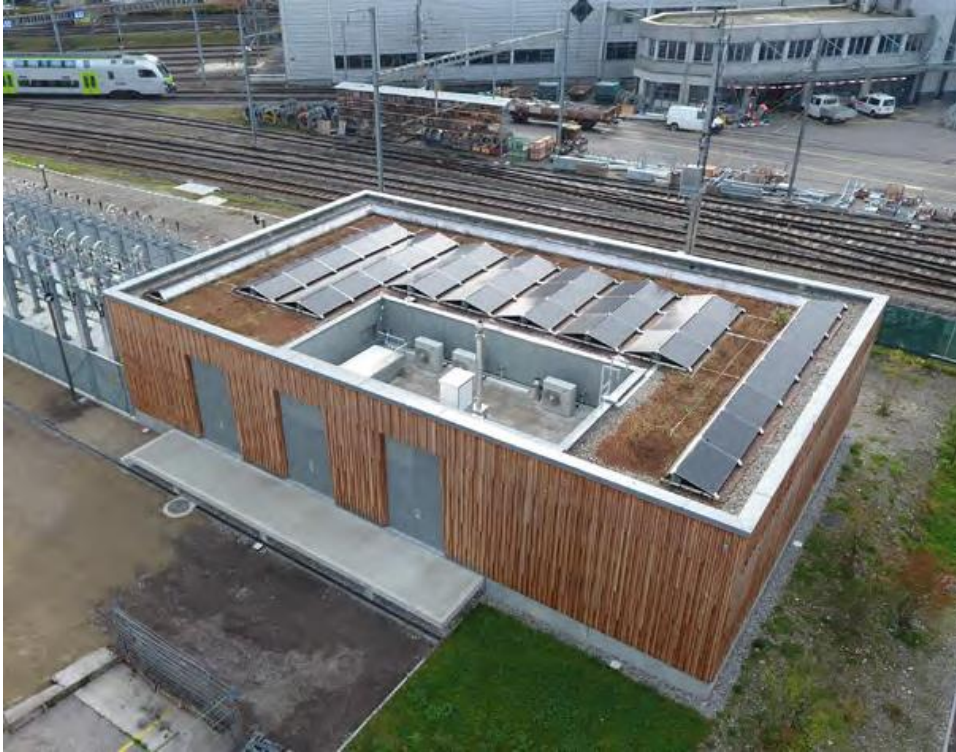
Abbildung 14: Schaltstation Holligen, mit PV-Anlage auf dem Dach, Bild: BLS AG, Pascal Mürger
