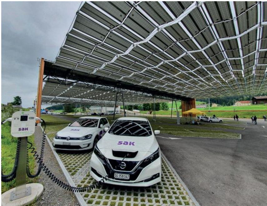
Abbildung 25: Solarfaltdach über dem Parkplatz der Luftseilbahn zum Kronberg, Bild: SAK
