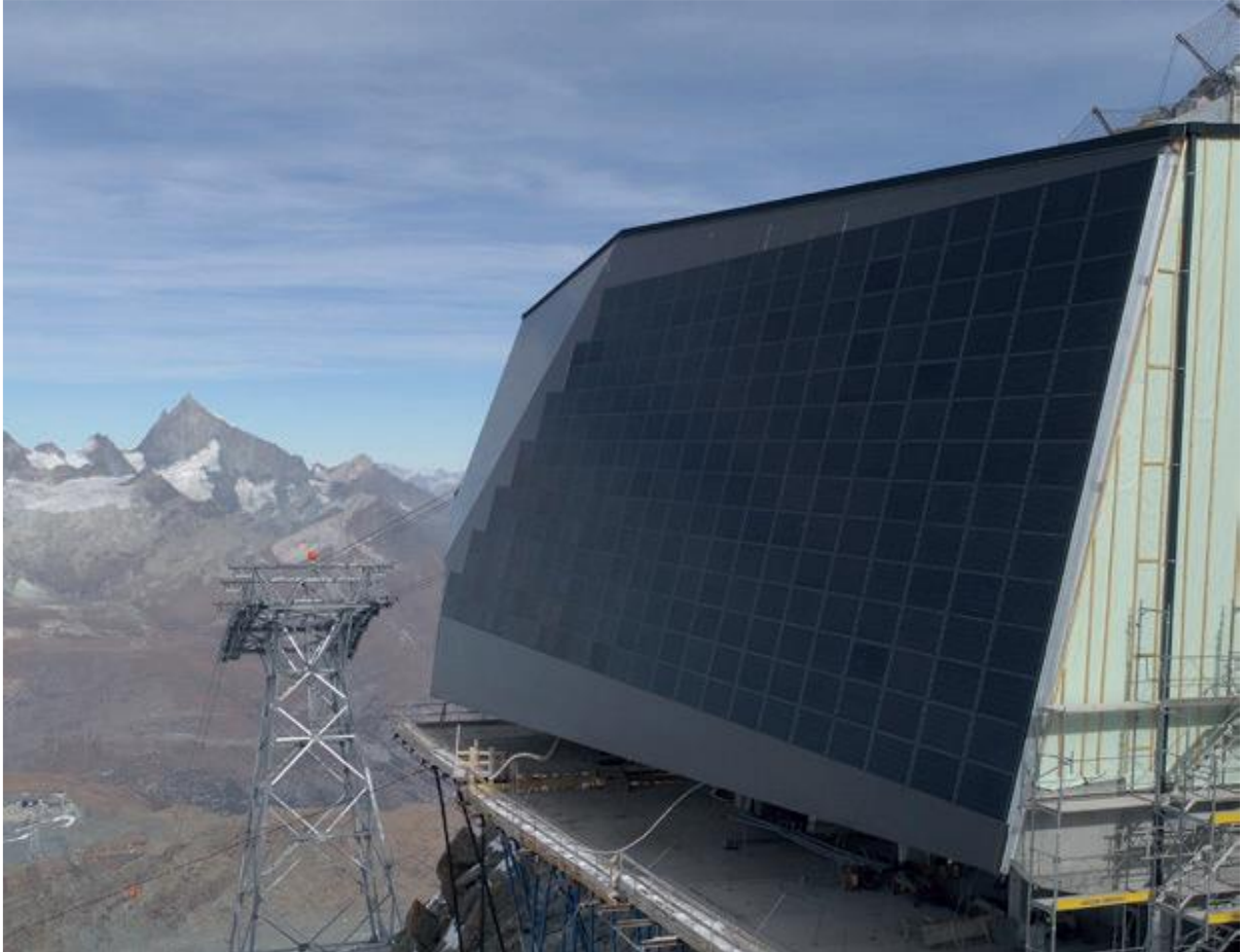
Abbildung 9: Bergstation mit PV-Fassade, Bild: Zermatt Bergbahnen AG
