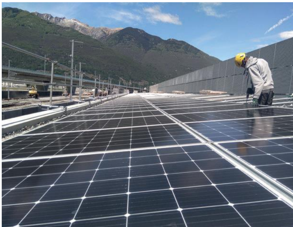
Abbildung 28: Bahntechnikgebäude Camorino Foto: Evolve SA
