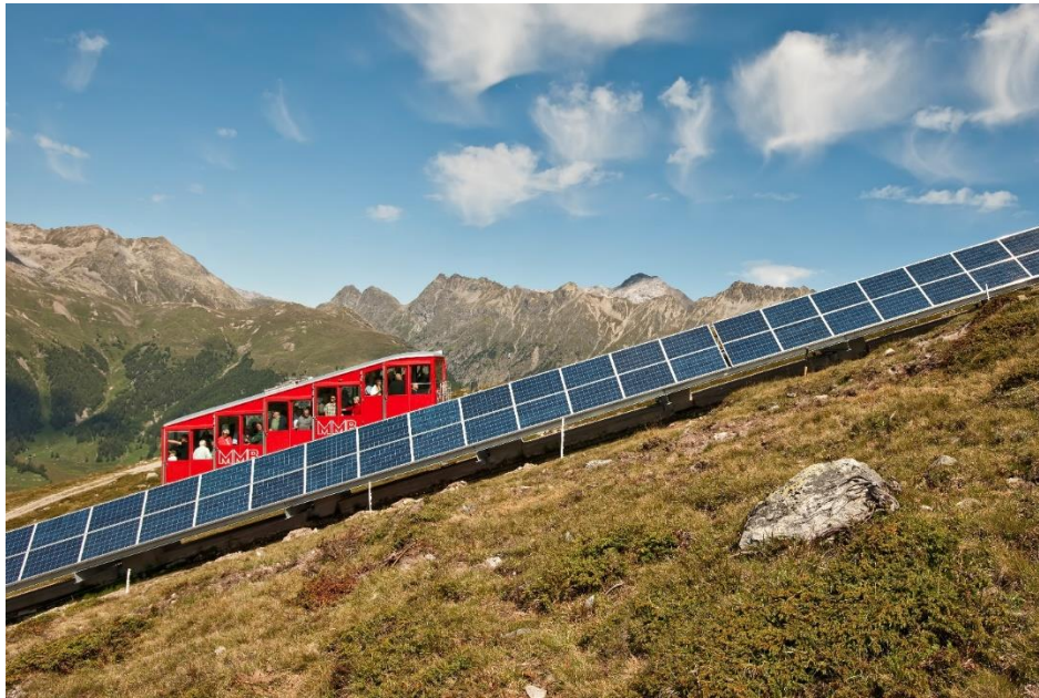
Abbildung 6: PV-Anlage an Bahntrasse Standseilbahn, Bild: Engadin St. Moritz Mountains / kmu-fotografie.ch
