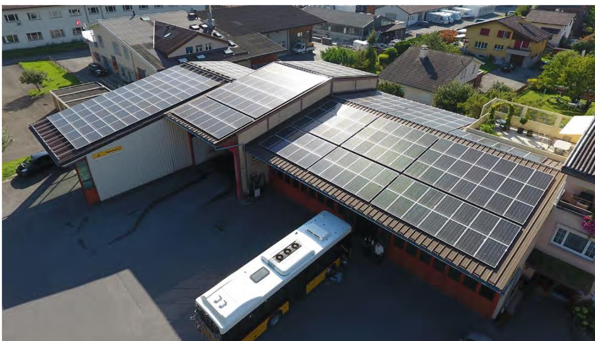
Abbildung 23: Hallen der Karl Gessinger AG in Bad Ragaz, Postauto-Unternehmen, Bild: Firma Pfiffner Elektrotechnik GmbH
