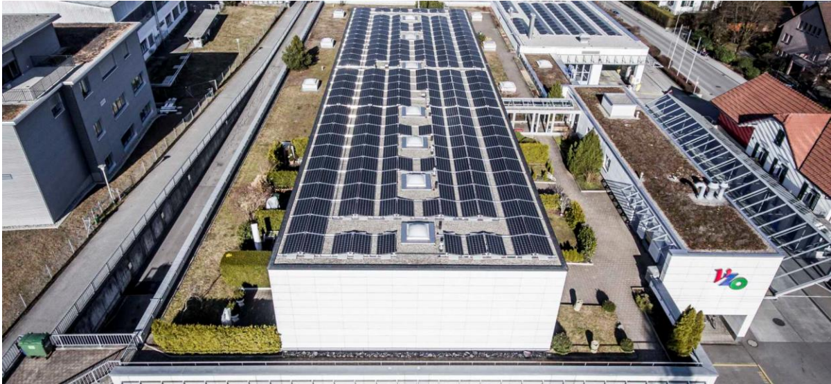
Abbildung 40: Dach der Busgarage in Grüningen, Bild: VZO, Christian Merz Fotografie
