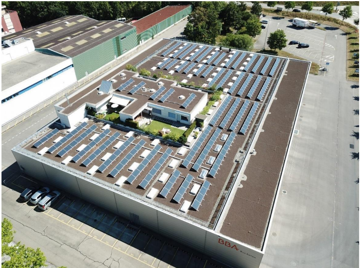
Abbildung 41: Busdepot Busbetriebe Aarau, Bild: Peter Baertschiger, Busbetriebe Aarau AG
