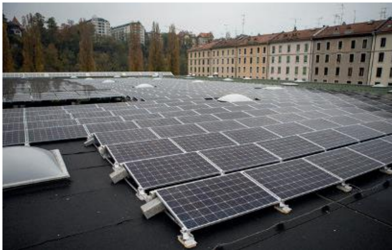
Abbildung 11: Dachfläche Dépôt de la Jonction, Bild: Pierre Albouy
