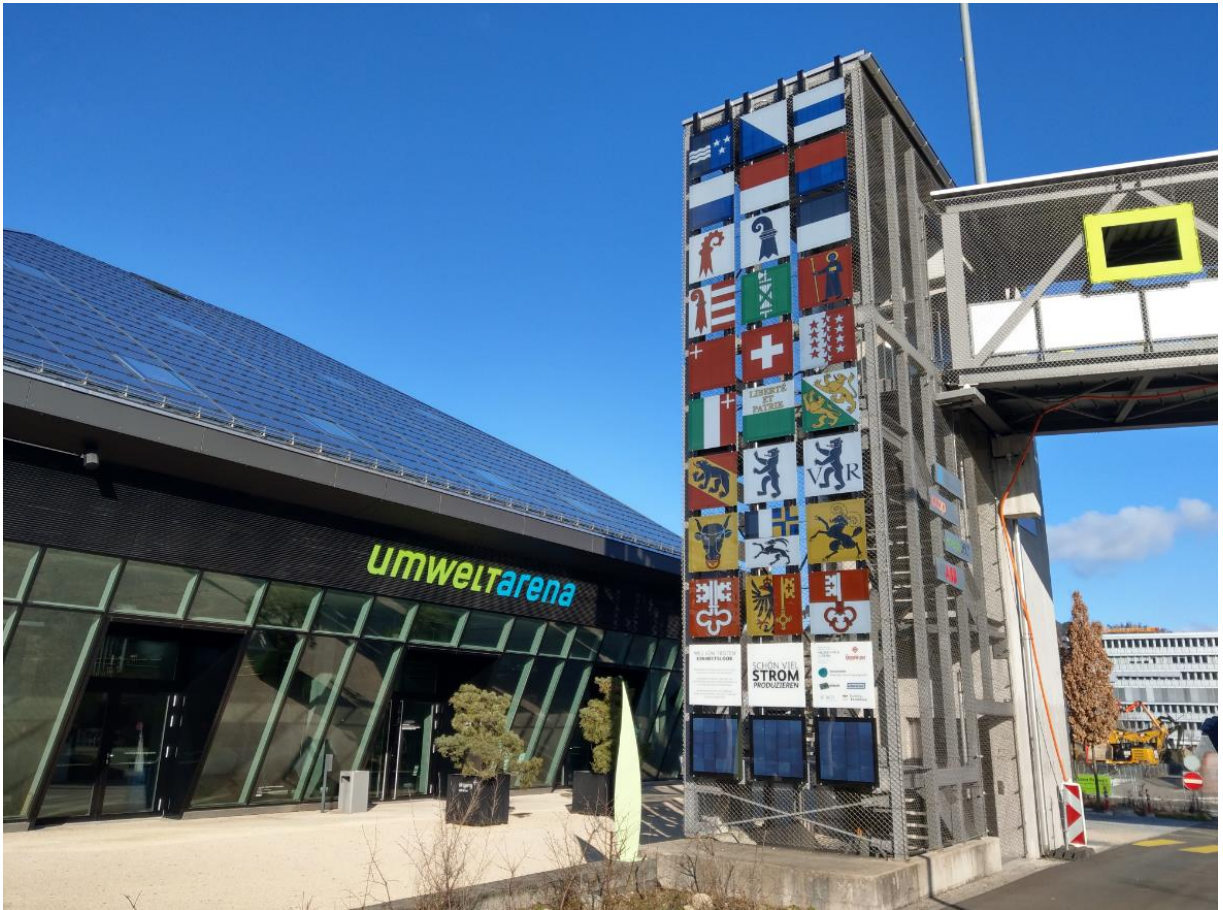
Abbildung 4: Farbige bedruckte PV-Module bei der Umweltarena Spreitenbach. Bei einzelnen Farben sind im Hintergrund die Solarzellen sichtbar, Foto: Christof Bucher, Basler & Hofmann
