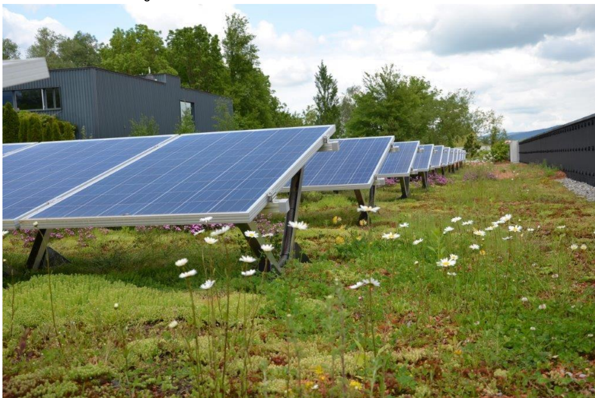
Abbildung 34: Dachbegrünung mit PV kombiniert, Bild: Contec
