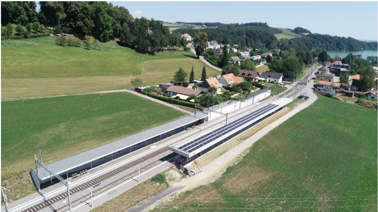
Abbildung 24: PV-Anlage auf dem Perrondach der Haltestelle Pensier, Bild: TPF
