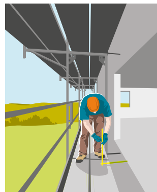
Regel 7 Gerüst kontrollieren.
