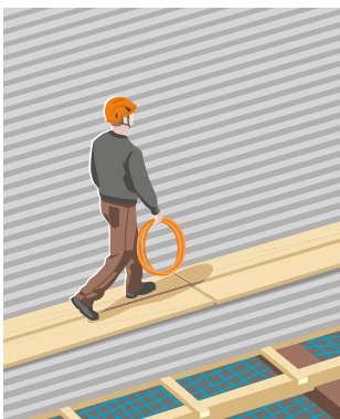
Regel 5 Durchbruch sichere Dachflächen.
