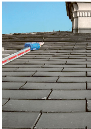
2 Dach mit asbesthaltigen Faserzementplatten
